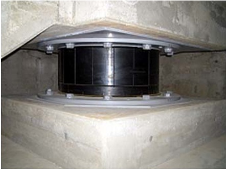
これだけで上部の荷重を支える 免震ボルト
