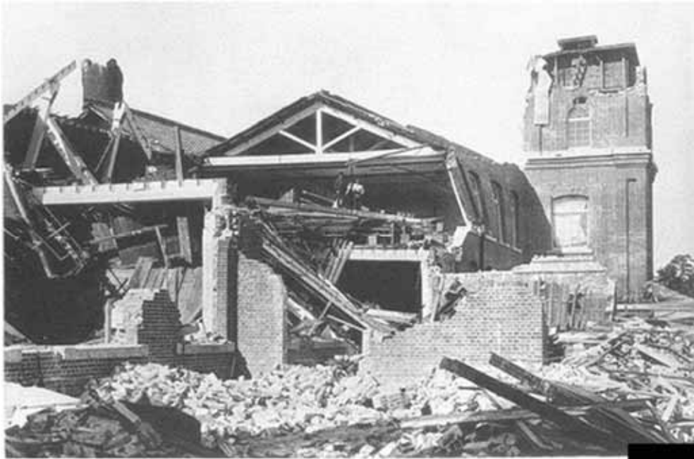
濃尾地震により破壊された旧尾張紡績の工場 [現在の名古屋市熱田区]
